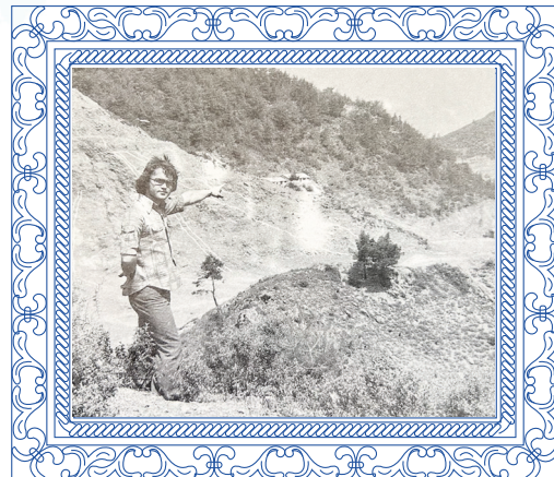
Barajın İnşa Edildiği Vadi (1966)
